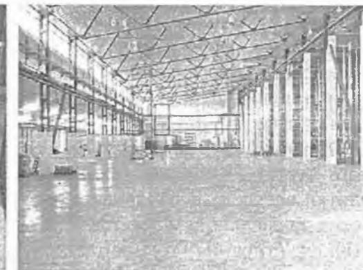
Рис. 16.2. Наливні бетонні підлоги в інтер'єрі промислового приміщення
