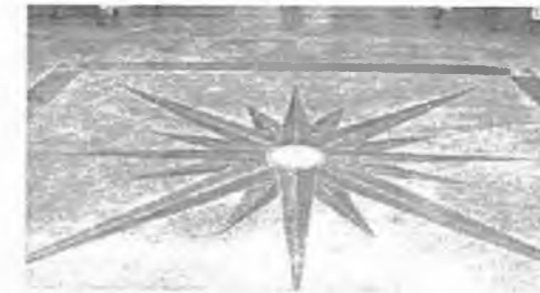
Фото 31. Влаштування підлоги з використанням технології «кислотного фарбування» бетону
