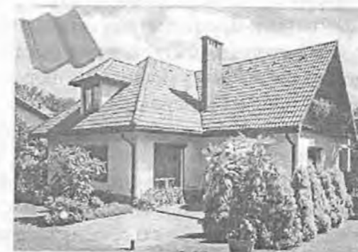
Рис. 7.14. Влаштування даху із бетонної черепиці
