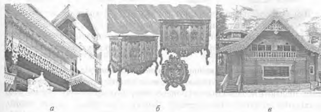
Рис. 8.8. Види різьблення деревини: а — прорізне (ажурне), б — скульптурне (об'ємне), в — рельєфне
