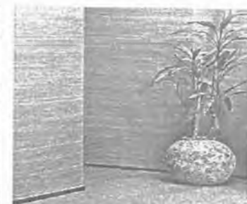
Фото 60. Джугові шпалери в інтер'єрі житлового приміщення
