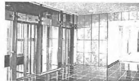
Фото 4. Кам'яний шпон в облицюванні вестибюлю офісного приміщення
