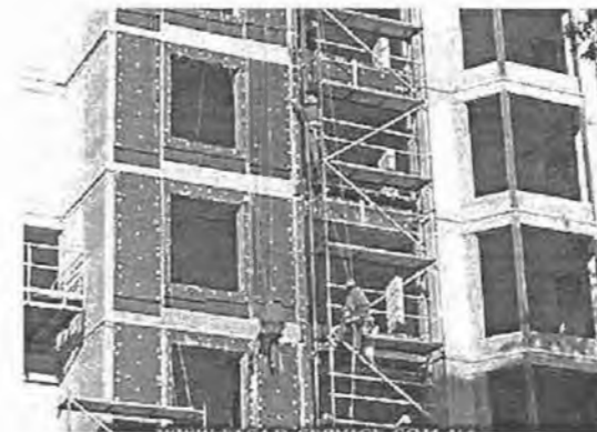
Рис. 12.6. Влаштування теплоізоляції фасаду житлового будинку з використанням екструзійного пінополістиролу
