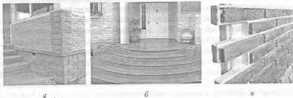
Рис. 4.8. Фасад (а) та сходи (б), оздоблені клінкерною плиткою; термopanелі із клінкерної плитки (в)
