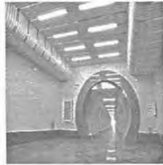
Фото 54. Стелі з металевих панелей в інтер'єрі громадської будівлі
