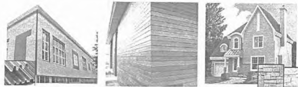
Фото 49. Влаштування фасаду з використанням сайдингу: а — сталюого, б — дерев'яного, в — цементного
