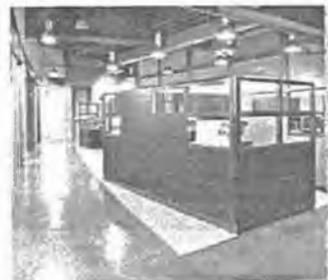
Фото 22. Влаштування підлоги з бетону, що змінює колір (бетон-екран) (Chronos Chromos Concrete)
