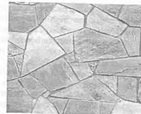
Рис. 3.6. Влаштування доріжок із використанням плит неправильної форми із сланцю та пісковика
