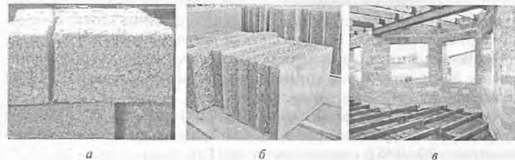
Рис. 8.23. Блоки (а) й плити (б) та будівництво стін малоповерхової будівлі з арболіту (в)
