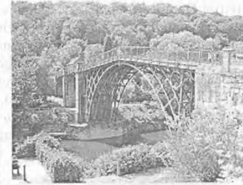
Рис. 1.16. «Залізний» міст через р. Северн, Англія
