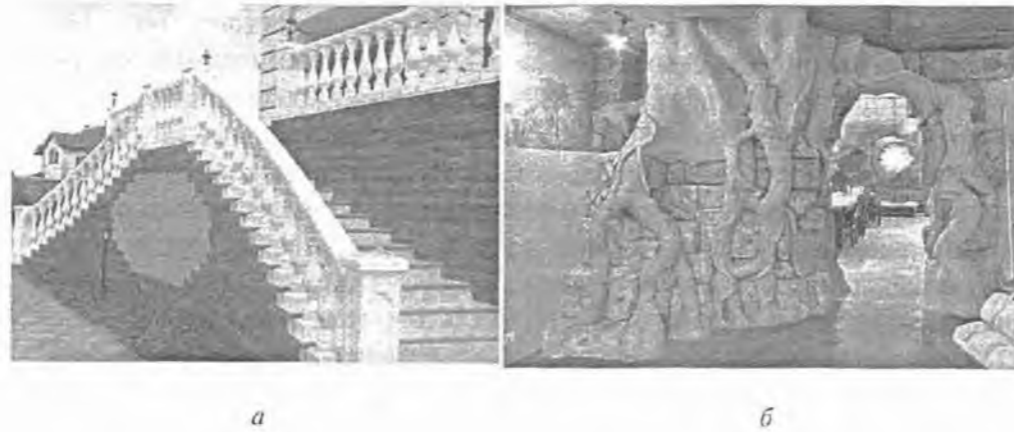
Рис. 10.2. Використання полімербетонів: а — в екстер'єрі (влаштування елементів сходів), б — декорування стін в інтер'єрі
