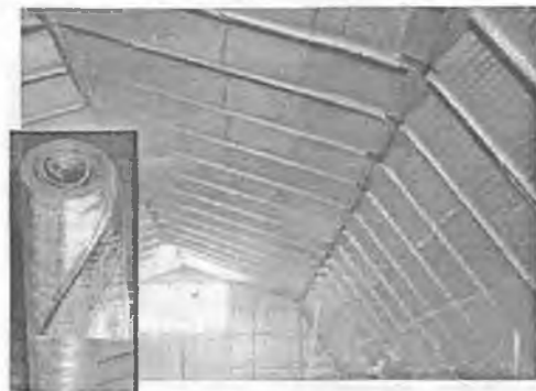
Рис. 6.12. Влаштування відбивної теплоізоляції на горищі
