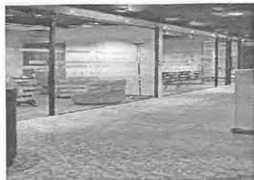
Рис. 5.22. Влаштування підлоги офісного центру з використанням ситалових плит
