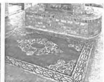
Фото 30. Трафаретний бетон для влаштування підлоги
