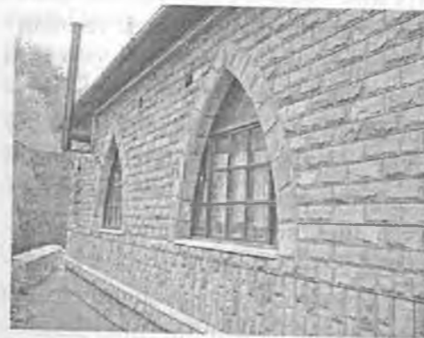
Рис. 3.3. Облицювання фасаду плитами скельної фактури з пісковіку
