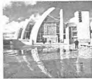
Фото 23. Ювілейна церква (Jubilee Church) з використанням бетону, здатного до самоочищення, м. Рим (Італія)
