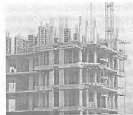
Рис. 7.9. Зведення конструкції будівлі з монолітного залізобетону
