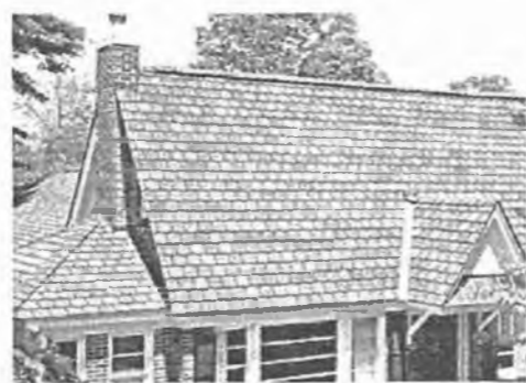
Рис. 14.2. Влаштування покрівлі з використанням цементної черепиці
